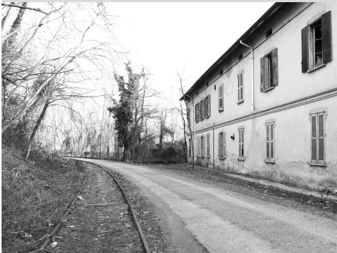
Cairate (Varese), 2011. Ferrovia Valmorea e scuola Vita Mayer. La Vita Mayer aveva attivato una scuola per l'avviamento al lavoro di durata triennale, non distante dalla Cartiera di Cairate e in prossimità del percorso della ferrovia della Valmorea, poco prima di arrivare alle aree di scarico della cartiera.
