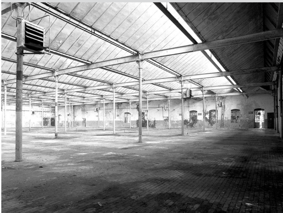
Castellanza (Varese), 2011. Cottonificio Cantoni: reparti tessitura. Parte non recuperata del cotonificio, costituita da un'ampia struttura con tetti a shed su un unico piano, dalla parte opposta del fiume Olona, rispetto alla più imponente mole di edifici a più piani in cui ha sede l'Università.
