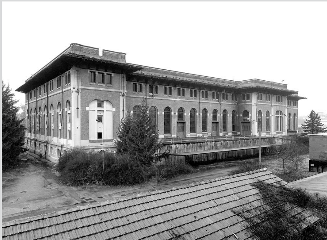
Castellanza, 2011. Centrale. Edificio principale della centrale, che conserva le forme dell'impianto originale, mentre le due alte ciminiere, poste ai lati, sono state demolite.
