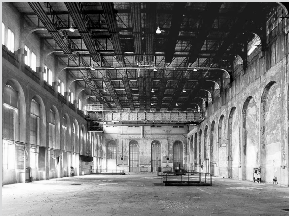
Castellanza, 2011. Centrale. Edificio principale della centrale. Una delle due sezioni dell'edificio principale, destinato alla manutenzione.
